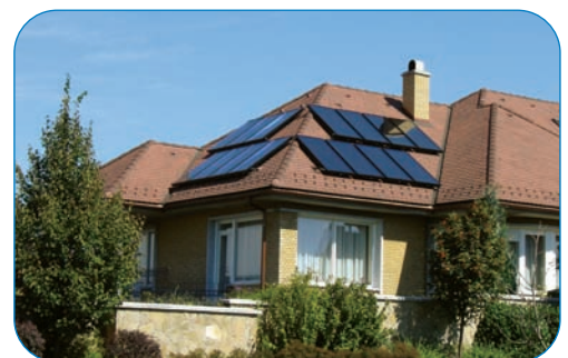
Családiház 2 irányú síkkollektor rendszer Somogy megye
